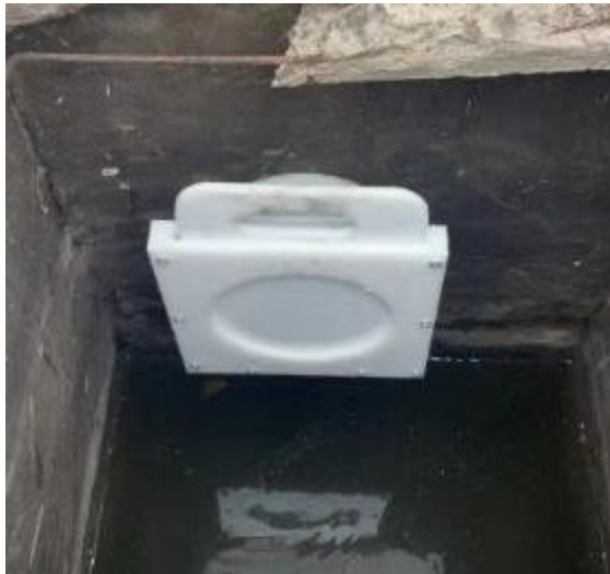
图 4-3 雨水截止阀示意图
